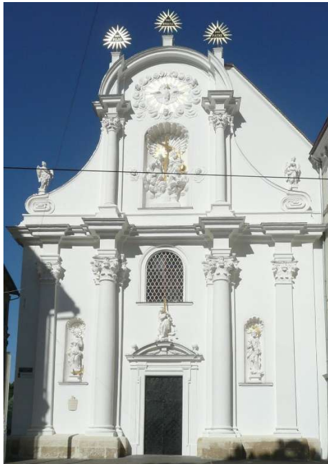
Dreifaltigkeitskirche Graz, Fassade © Zottmann GmbH 2012
